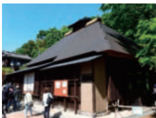
写真1 大沢の里古民家
