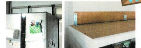
冷蔵庫の転倒防止事例 L字金具を使用した転倒防止事例
