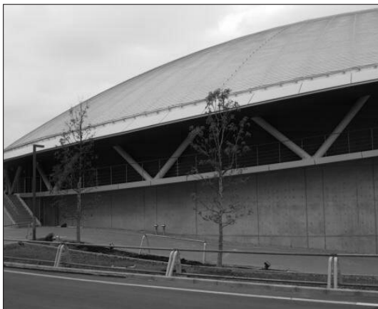
写真 4-7：新たな千葉競輪 (千葉 JPF ドーム) の外観 (2021年：筆者撮影)
