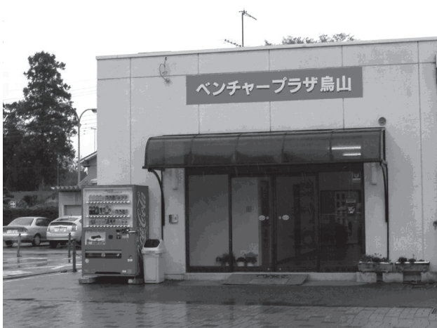
図3 インキュベーション施設「ベンチャープラザ烏山」の正面と内部
