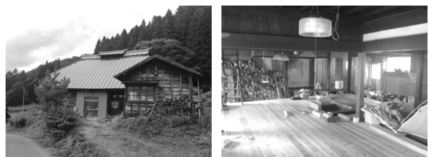
◇図12：民泊提供者が行なっている古民家再生 (出典：筆者撮影)
